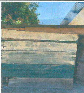
Foto 1: Mejoramiento de cubierta de bodega escolar.
